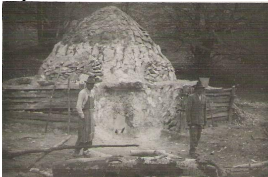
1. kép: Mészégetés a Bükkben: mészégető kemence (forrás: A Bükkben a fuvaros az úr | Száz Magyar Falu | Kézikönyvtár )
